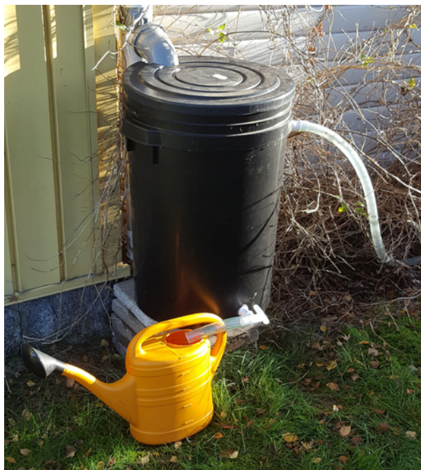
Regnvattentunna med utledning till rabatt.
