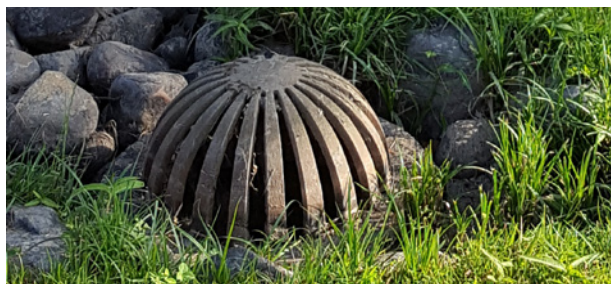
Rännstensbrunn och kupolbrunn.
